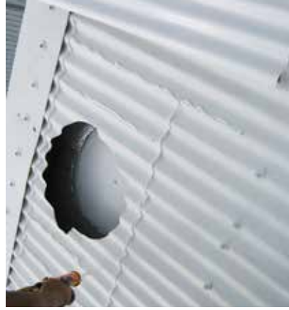
2ème phase d'étanchéité sur toiture (colle mastic sur tout le pourtour)
