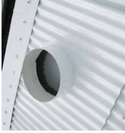
1ère phase d'étanchéité sous solin (bande mousse anti remontée d'eau par capillarité)
