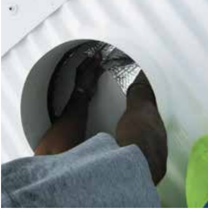
Libération de l'isolation pour passage du conduit
