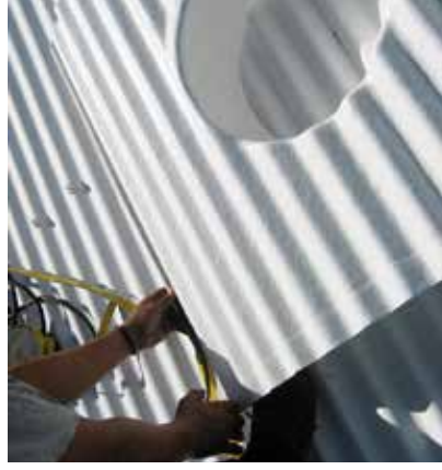
Début du perçage de la tôle
