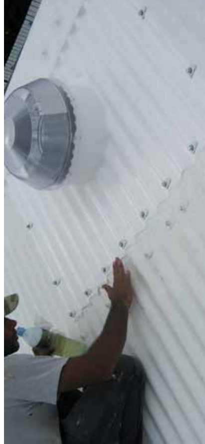
Mise en place de l'anneau de dôme
