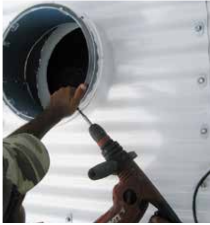
Libération de l'isolation pour passage du conduit
