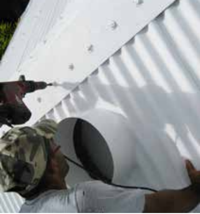
Fixation du faitage par vis auto perfo à tête inox + bouchon de protection
