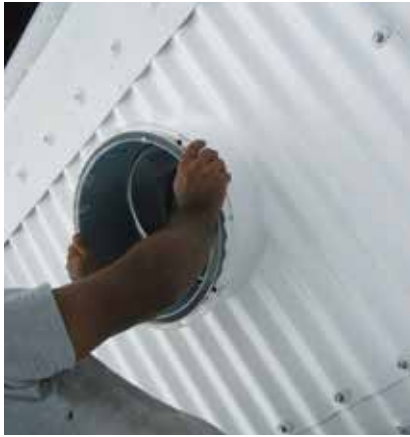
Mise en place de l'anneau de dôme
