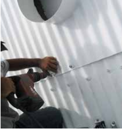
Fixation du solin à l'aide de vis auto perfo à tête inox + bouchon de protection
