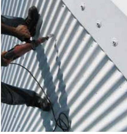
Début du perçage de la tôle
