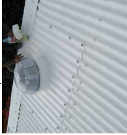
Fixation du solin à l'aide de vis auto perfo à tête inox + bouchon de protection
