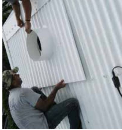
1ère phase d'étanchéité sous solin (bande mousse anti remontée d'eau par capillarité)
