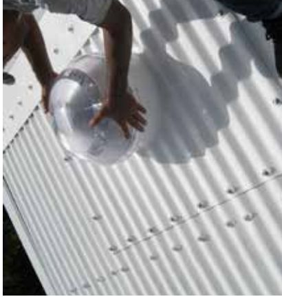
Fixation du faitage par vis auto perfo à tête inox + bouchon de protection
