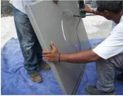
1 Préparation du solin d'étanchéité, découpage et pliage
