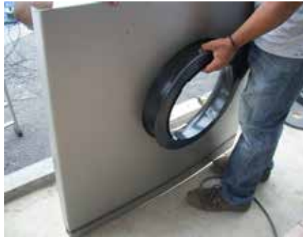
5 Incorporation de la partie basse de l'extracteur dans le solin d'étanchéité.
