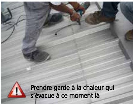
7 Repère puis découpage à la grignoteuse du trou diamètre 42 cm dans la tôle de toiture.
