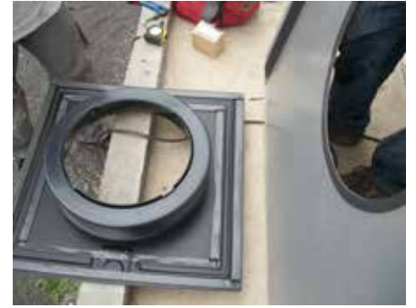
3 Démontage des deux parties de l'extracteur et mise en place de bandes mousses anti-remontées capillaires
