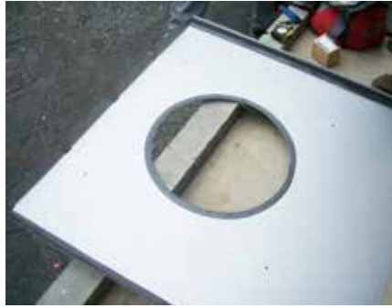
2 Mise en place de bandes mousses anti-remontées capillaires
