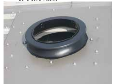
12 Mise en place de colle mastic entre la tôle solin et la partie basse de l'extracteur pour consolider l'étanchéité
