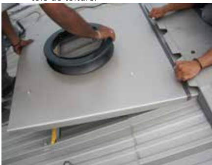
10 Mise en place du solin sous la partie démontée du faîtage
