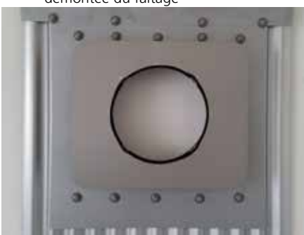
13 Mise en place d'une jupe de protection (anti-intrusion d'eau de pluie)
