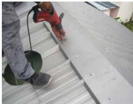
8 Démontage du faîtage au niveau de l'extracteur seulement
