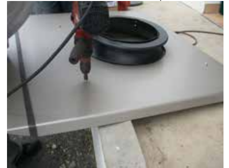
6 Fixation du bas de l'extracteur avec le solin d'étanchéité
